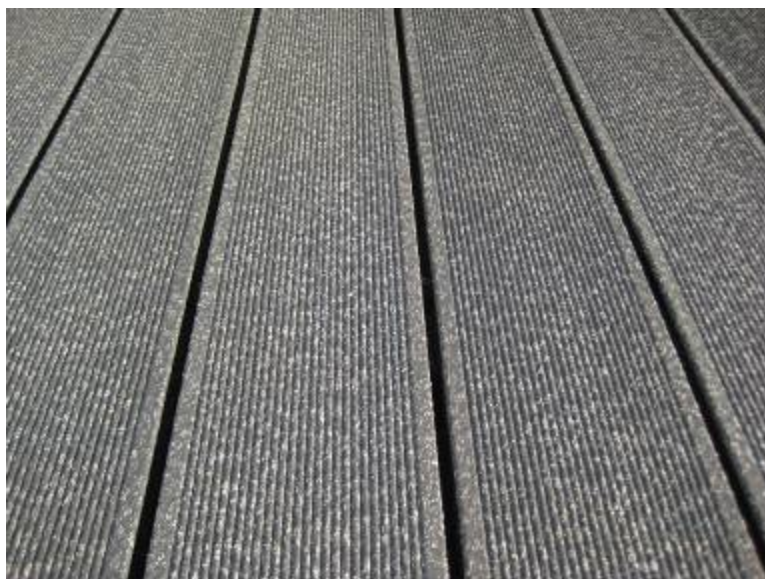
Primo piano di strutture per pavimentazione esterna in WPC
